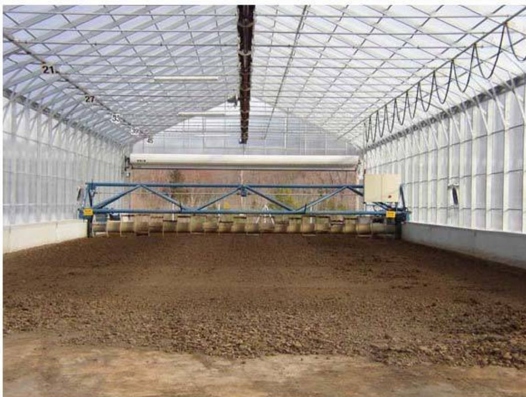
Εικόνα 4.2.: Φωτογραφία από τις εγκαταστάσεις ξήρανσης στη Γερμανία
